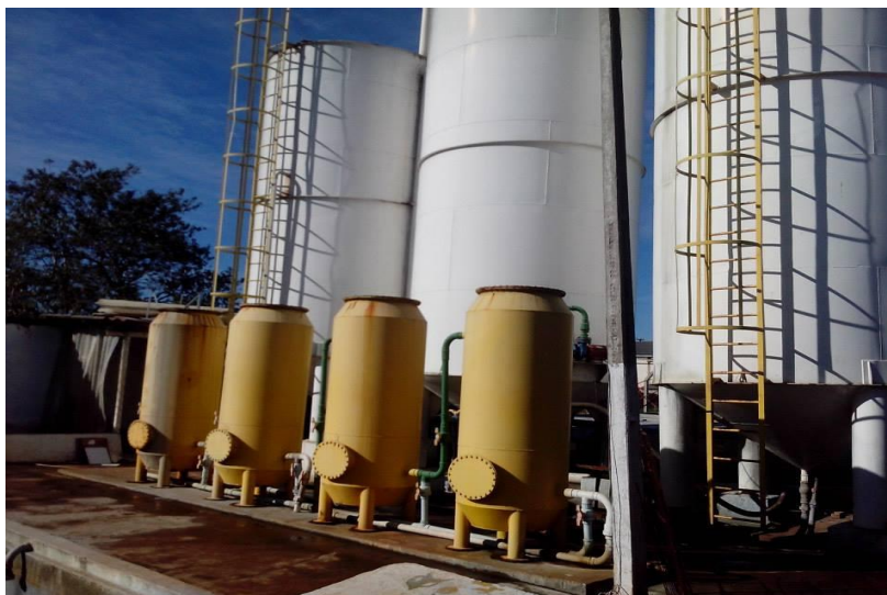
Figura 4 – Tanques floccodecantadores
